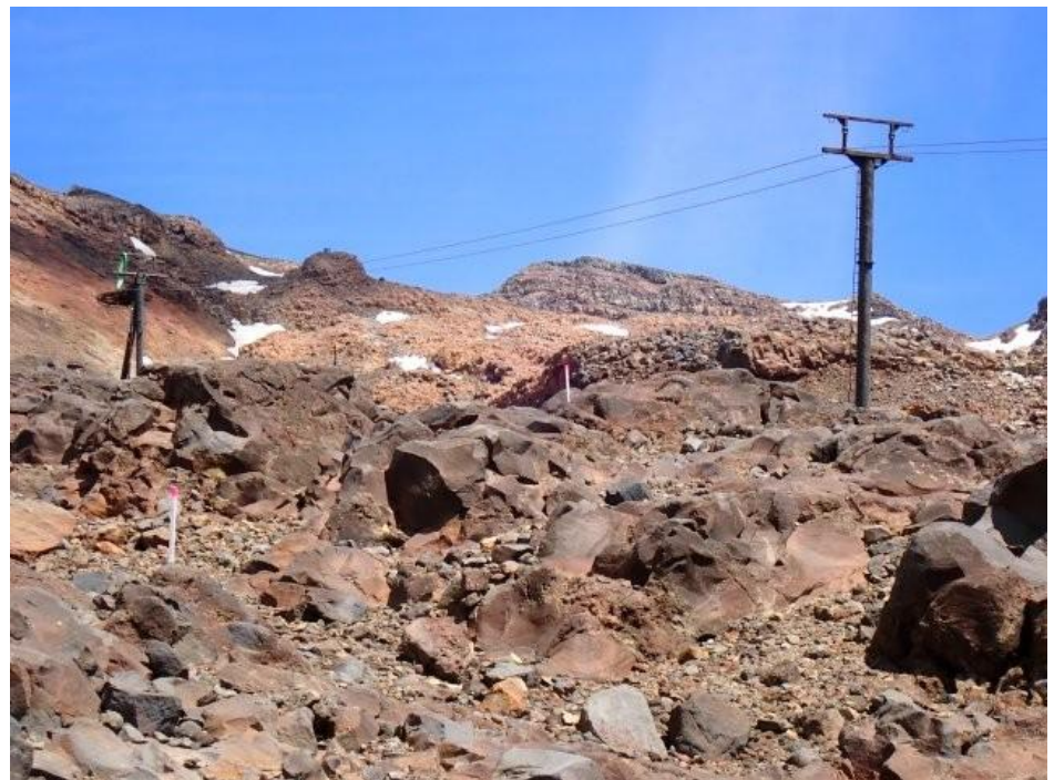
岩尾根より最後のリフトの 支柱手前の谷を渡りリフト 支柱を目指して下山した 〔奥が最後のリフト支柱〕
