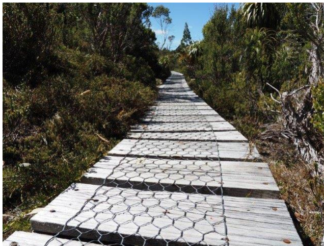
金網で補強された木道が続く
